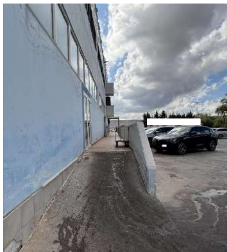
(Rampa di accesso)
