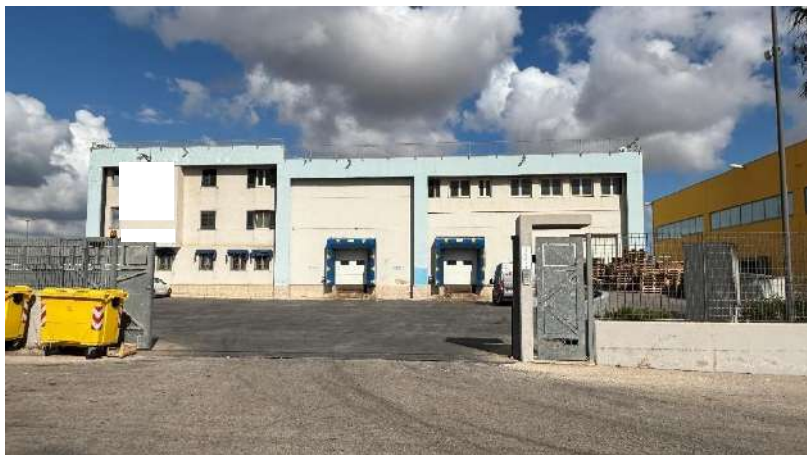
(Vista ingresso carrabile e pedonale)
